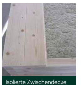
Isolierte Zwischendecke
