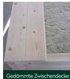
Gedämmte Zwischendecke
